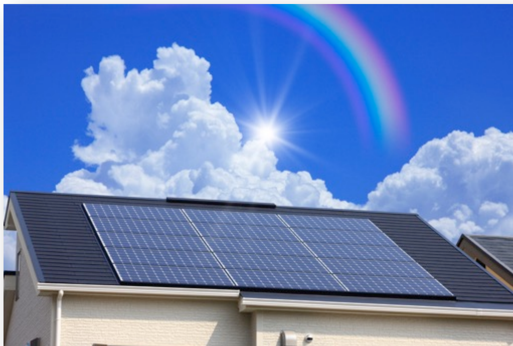
家庭への太陽光発電設備導入
